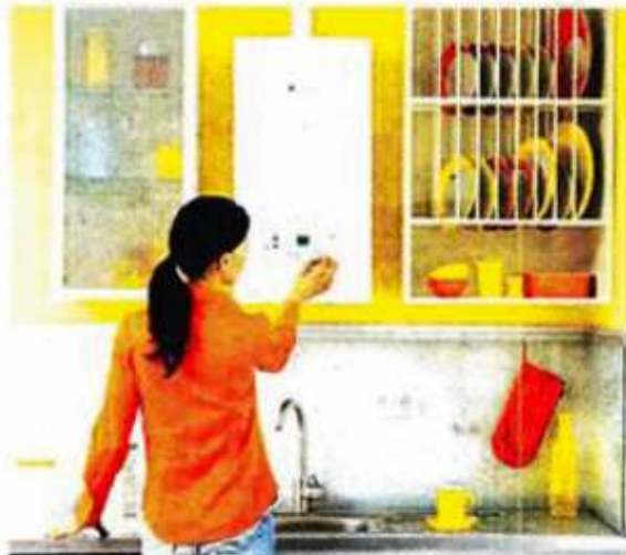
Stare plinske uređaje treba zamijeniti novima
